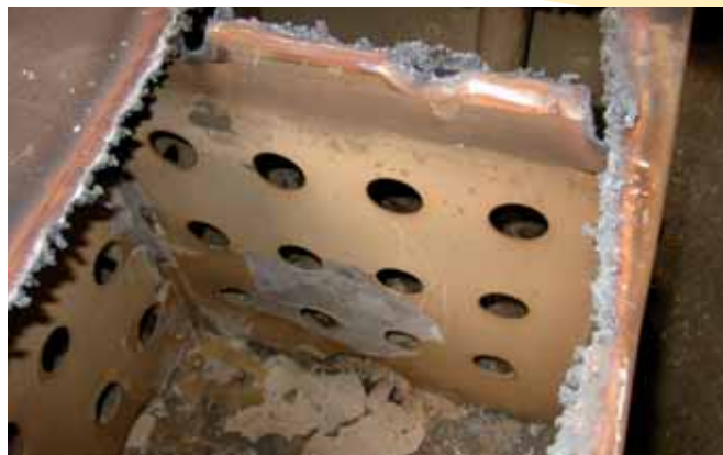
Утайки и остатъци по стените и дъното на водна цистерна — Източник: ISPEL
