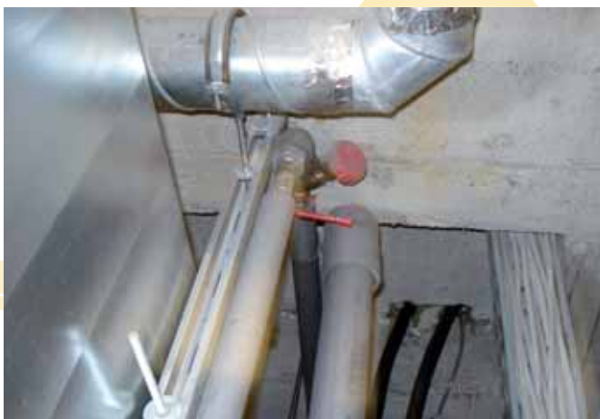
Скрит затворен кръг в системата с циркулация на топла вода, която предоставя възможност за развитие на легионела — Източник: OMF1
